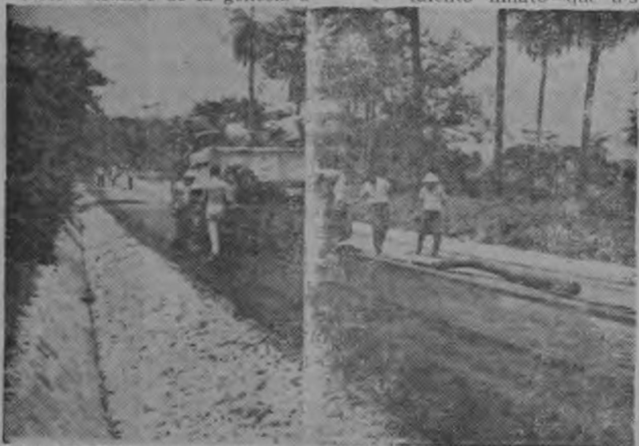
CARRETERA LA IRMA—JUNTAS DE ABANGARES, en uno de los tramos finales de su construcción. La obra tiene una extensión de 6 kilómetros y medio y une a la Carretera Interamericana, con la Ciudad de Abangares. Tiene un costo de millón y medio de colones.
